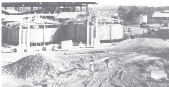
Photo 1 : Usine I de traitement des minerais
